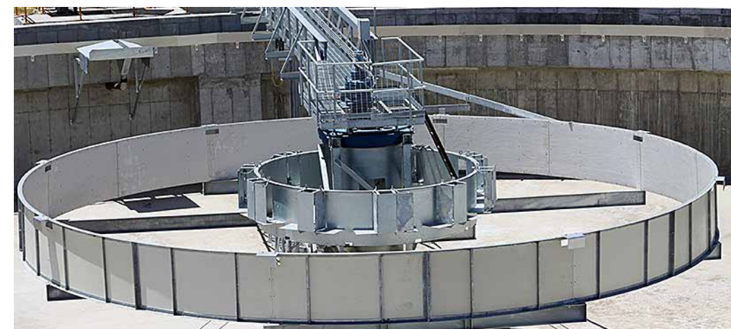
◀ Planta de Tratamiento de Aguas Residuales Noreste
