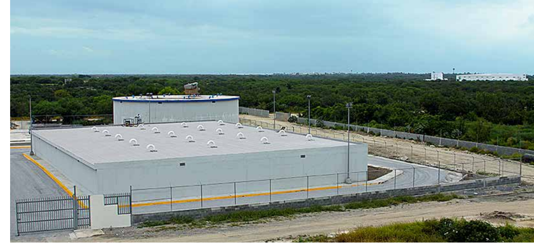
◀ Estación de Bombeo Nueva Castilla III
