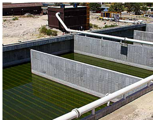
Ampliación de PTAR Noreste
